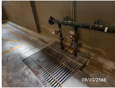
เครื่องสูบน้ำระบบระบายน้ำในอาคาร
